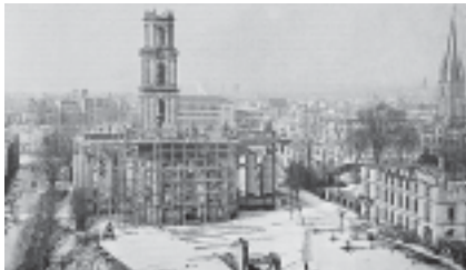
Beginn des Wiederaufbaus der Ludwigskirche, Saarbrücken 1947 vgl. J.A. Schmoll gen. Eisenwerth: Erinnerungen an erste Begegnungen mit der Saarbrücker Ludwigskirche. In: Festschrift zur Wiederindienstnahme der Ludwigskirche, Saarbrücken, 1982. Hrsg. von Pfr. H. Heydt, S. 209-224
